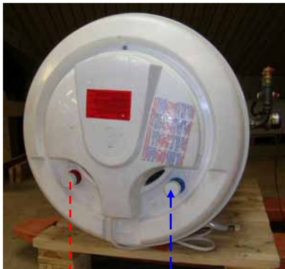
Base do cilindro Saída de água pré-aquecida Entrada de água fria
