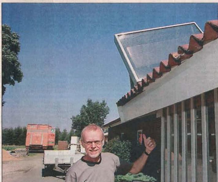
En Solar Venti kan placeres på mange forskellige måder, for eksempel lodret på en mur eller skråtstillet på taget. Hans Jørgen Christensen har adskillige eksemplarer installeret rundt omkring på virksomheder
